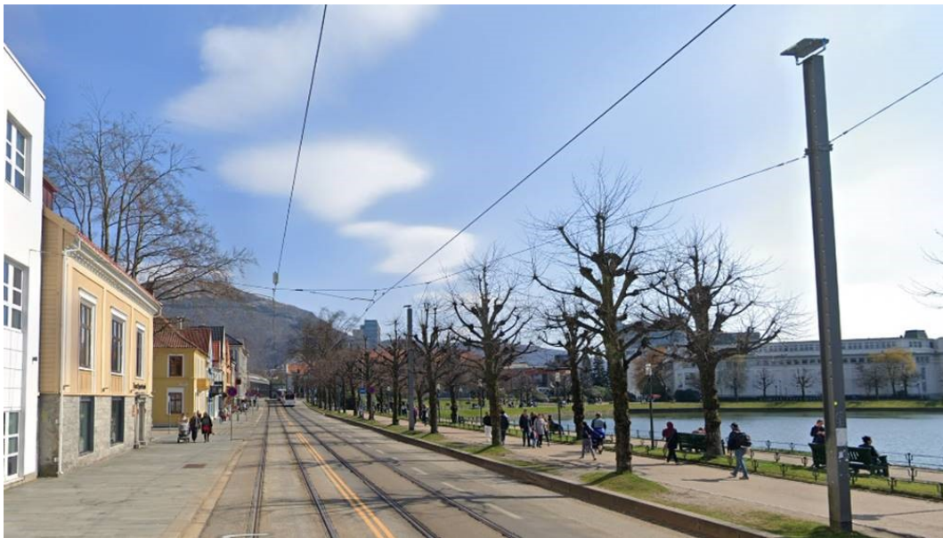
Foto fra master og enkel kjøreledning langs Kaigaten, her er kjøreledning festet i husvegg på den ene siden. Samme type ledningsanlegg kan brukes dersom man setter opp master på hver side av banetraséen.
