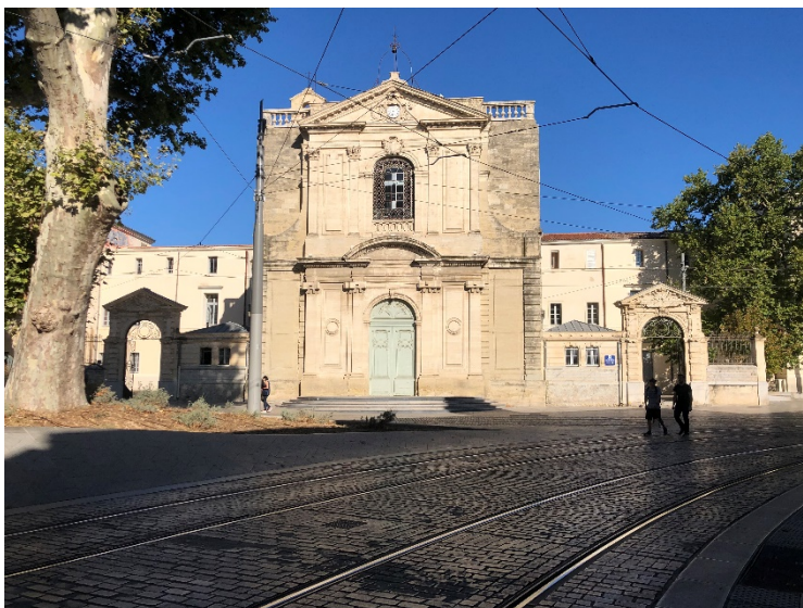
Foto fra Montpellier, master og kjøreledning.
