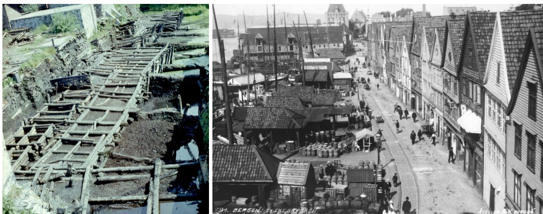
Figur 19 Til venstre den såkalte kong Sverres kai i bruk i perioden 1170-1198. Ved senere utfylling i Vågen inngikk kaien som fundament for bebyggelsen. Til høyre Bryggen mellom 1913 og 1920 (t.v.: Middelaldersamlingen, universitetsmuseet i Bergen, t.h.
