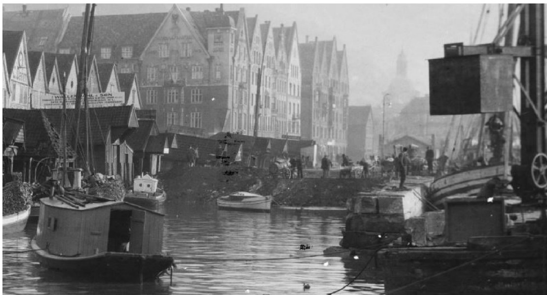
Figur 21 Detalj fra bildet over, man ser den nye kaifronten til høyre for midten av bildet. I bakkant fylles det masser i forlengelse av kaiutvidelsen fra 1899-1903.
