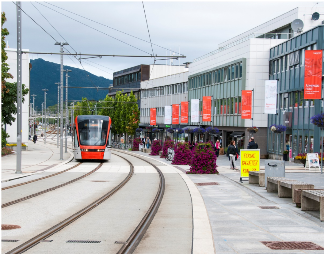
Foto fra master med «utligger» og enkel kjøreledning på Nesttun (2013).
