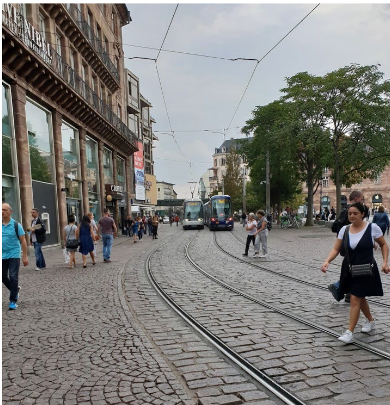
Foto fra Strasbourg. Her er kjøreledning festet i husvegg på den ene siden.
